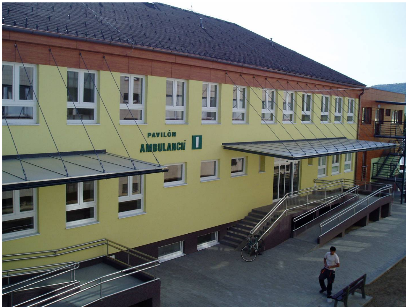
Pohľad na zrekonštruovanú budovu
